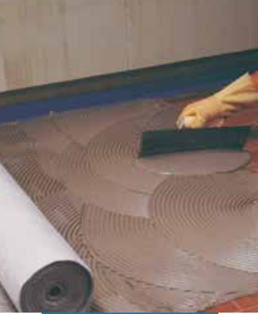
Az első réteg Mapelastic felvitele és azt követően a Mapetex Sel fektetése
