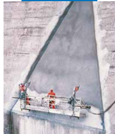
Példa Mapelastic szórásos felhordására gátra
