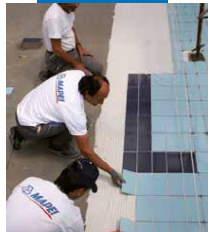
Kerámia burkolólapok fektetése Mapelastic-ra úszómedencében
