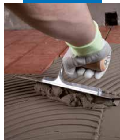
Granirapid felhordása Mapelastic-kal vízszigetelt teraszra
