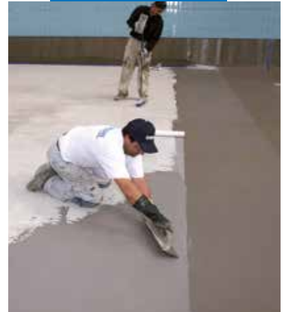
Úszómedence vízszigetelése Mapelastic-kal
